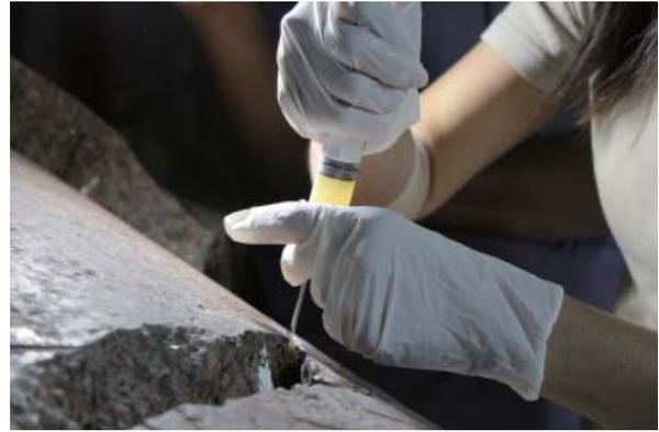
図7 隙間の充填作業風景
